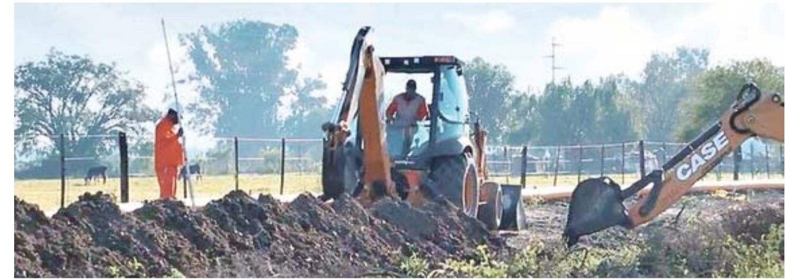
En su trazado, el gasoducto cruzará por debajo del lecho del río Salado y la laguna Setúbal, para llevar gas natural desde Esperanza hasta Arroyo Leyes, con una extensión total de 47.250 metros de cañería. FOTO: GENTILEZA
