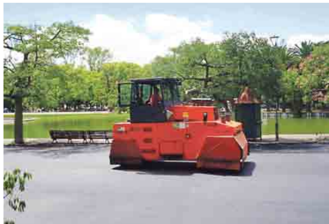
Se están ejecutando mejoras en los predios deportivos donde se disputarán las disciplinas como el Estadio Municipal Jorge Newbery con una gran obra en la pista de atletismo y trabajos de acondicionamiento en los clubes Newell's y Provincial. FOTO: GENTILEZA
